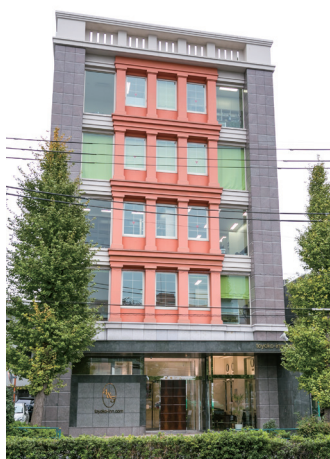
株式会社 東横イン 本社ビル外観(東京・蒲田)
