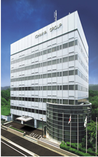
一宮グループセンタービル 外観
