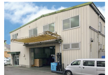
富田林工場 (大阪府富田林市)
