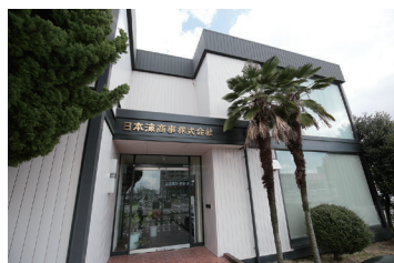
本社・富山営業所 外観
