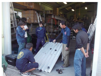
大波スレート施工研修
