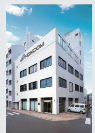
本社ビル外観
