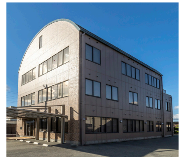
株式会社市川築炉 外観
