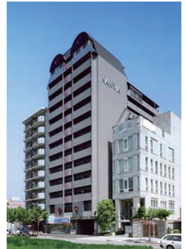
本社ビル外観
