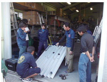
大波スレート施工研修
